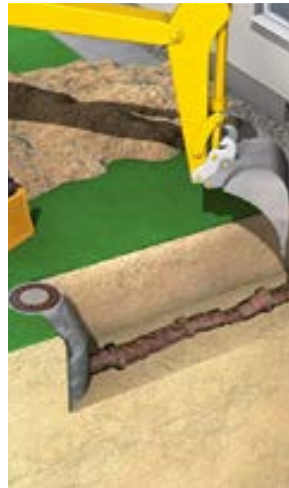
Erneuerung in offener Bauweise
