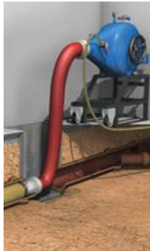
Schlauchliner in geschlossener Bauweise
